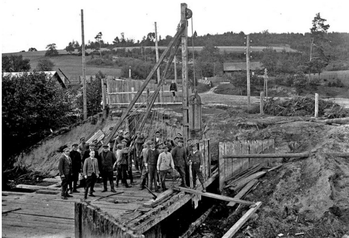
Naprawa zniszczonej przez powódź grobli i mostu na Wieprzu przy tartaku. Wbijanie pali kofarem ręcznym.
